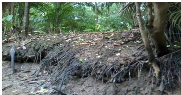
Figura 4 - Efeitos da erosão nas margens do rio Ubintuba.
