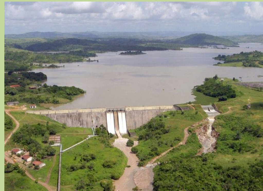
Componentes construídos Barragens
